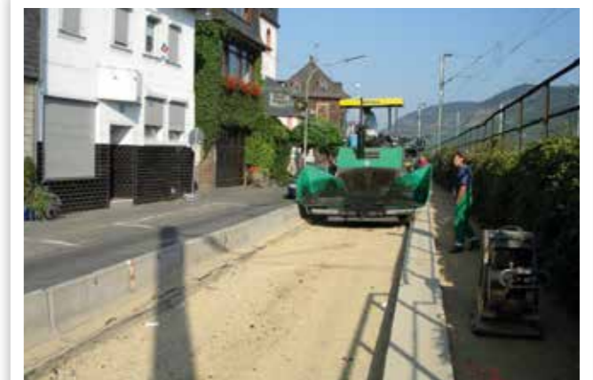
SANIERUNG VON KOMMUNALEN STRASSEN
