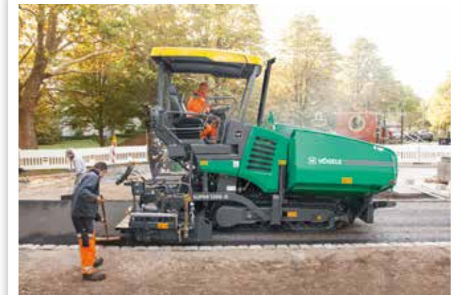
WEGEBAU IN PARKANLAGEN
