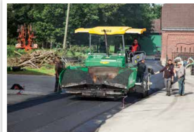
ASPHALTEINBAU AUF GEWERBLICH GENUTZTEN FLÄCHEN
