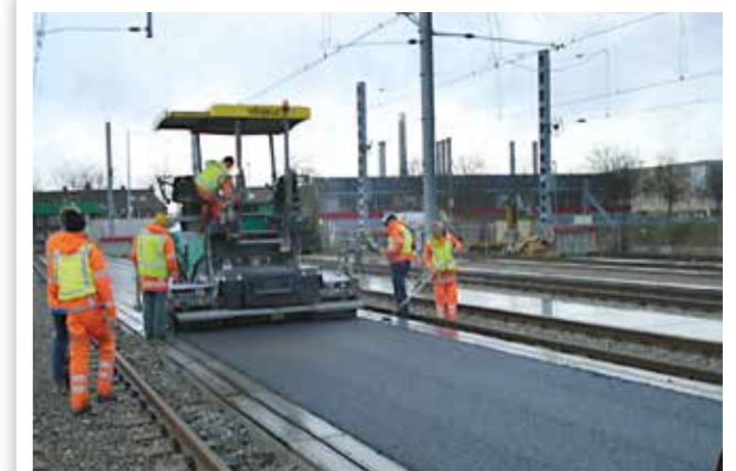
ASPHALTEINBAU AUF BAHNSTEIGEN
