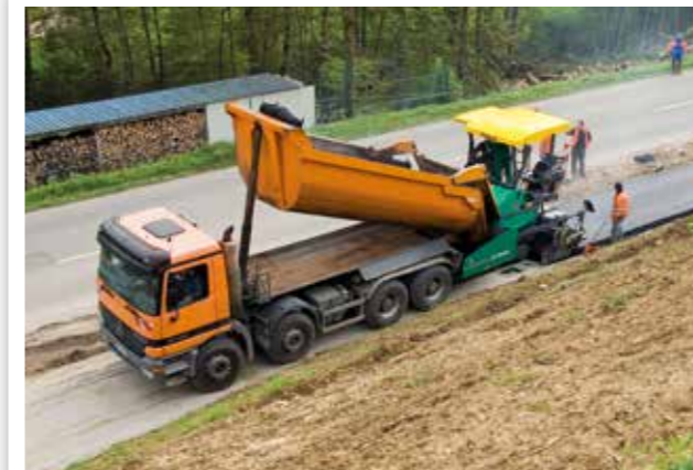
ASPHALTEINBAU BEI GEH- UND RADWEGKOMBINATIONEN
